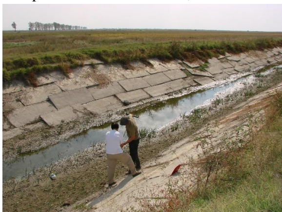
Canal de irigație din sistemul Brăila Nord aflat în reabilitare
