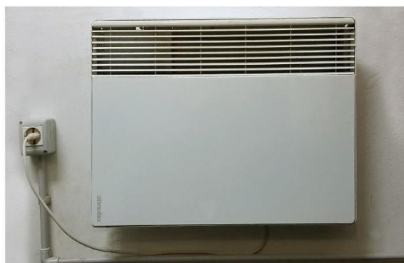
Convectori electrici cu termosenzori pentru încălzirea în spațiile de forțare
