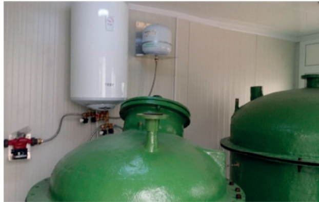
Fig. 3. Bioreactoare pentru fermentație uscată și umedă cu sistemul de încălzire (boiler electric)
