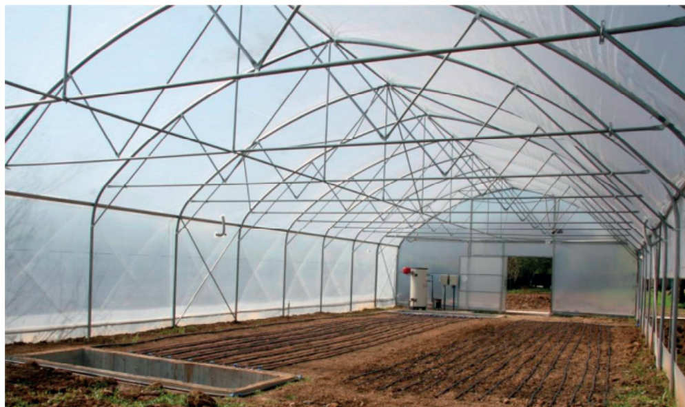
Sistem tehnologic inteligent de irigare prin condensare în sere și solarii - SII
